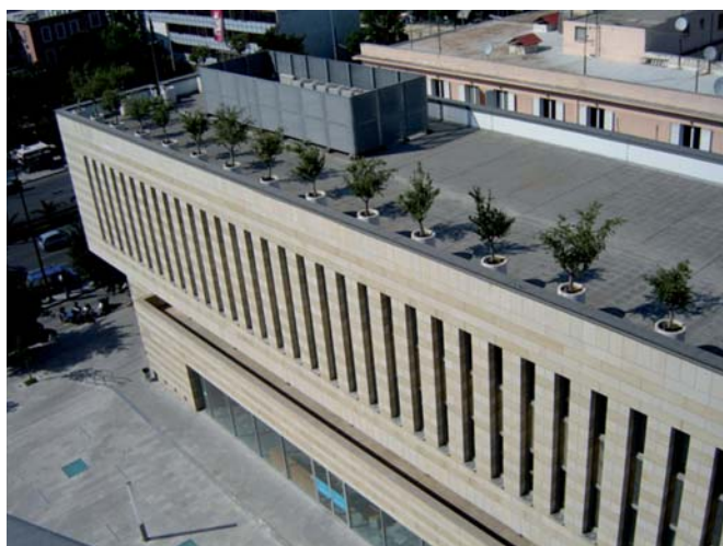
Fot. 11. Na dachu nowoczesnego i estetycznego budynku National Insurance agregaty chłodnicze nikną za osłonami akustycznymi i zielenią
